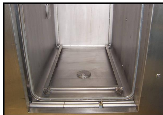
Komora po czyszczeniu:
